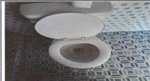
Foto 4: Sustrucción de inodoro y sus accesorios de baños.
