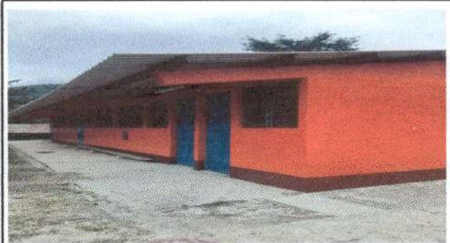
Foto 2: Pinturas en muros exteriores modulo aulas.
