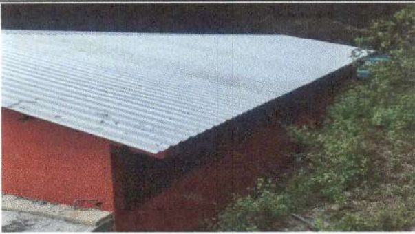
Foto 1: Sustrucción de lamina por lamina troquelada aluzinc calibre 26 modulo de aulas.
