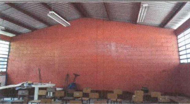
Foto 3: Pintura de muros interiores modulo de aulas.
